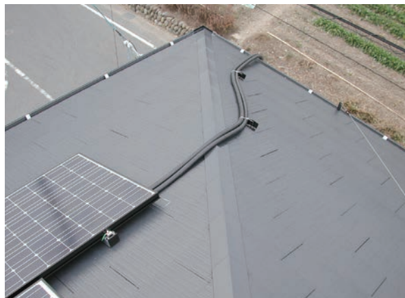
写真 屋根瓦をはじめ建物外観にも調和
