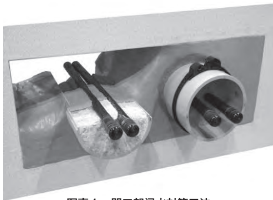
写真1 開口部浸水対策工法
