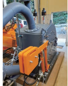
福井県坂井市川上小水力発電所 (横軸2射ペルトン水車 130 kW・2021年8月運転開始)
