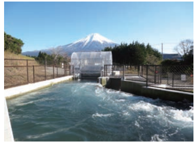
三峰川本門寺第一発電所 取水部
