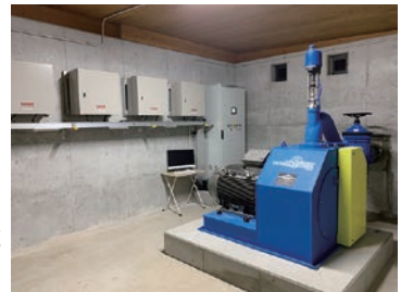
◀兵庫県宍粟市黒土川小水力発電所 (取り外し可能なCLT材屋根とRC半地下構造建屋)
