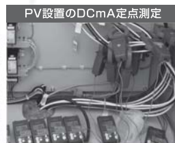
PV設置のDCmA定点測定
