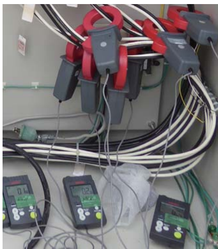
PV設備のDCmA定点点測定
