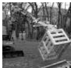
障害物を持ち上げる援竜。自身の安全のほか、被害者がいるかもしれない場所を踏むことがないよう長い腕で作業するスタイルになっている。
