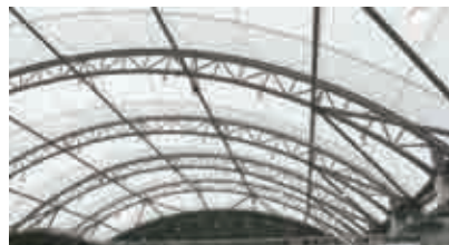
キラメッセぬまづの天井。
