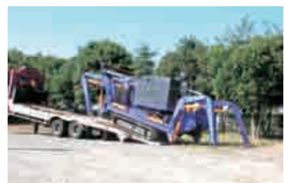
TITAN-XI は現場近くまでトラックで搬送され、降車後はクローラで工事現場の法面近くまでの整地を移動する。
