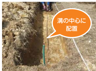
①溝を掘削し接地線を敷設
