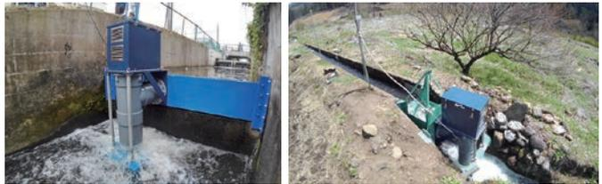
写真1 横断幅3mの水路への設置 写真2 横断幅70cmの農業用水路への設置
