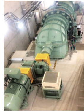
写真2 6000V級/S型チューブラ水車 大流量・低落差で適用
