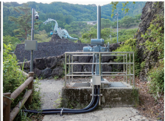
▲取水口。ここから金剛の滝上流の水を取り込み、ヘッドタンクへと送る。奥に見えるのは恐竜のオブジェだ(同社の設備ではなく、既設のもの)。
