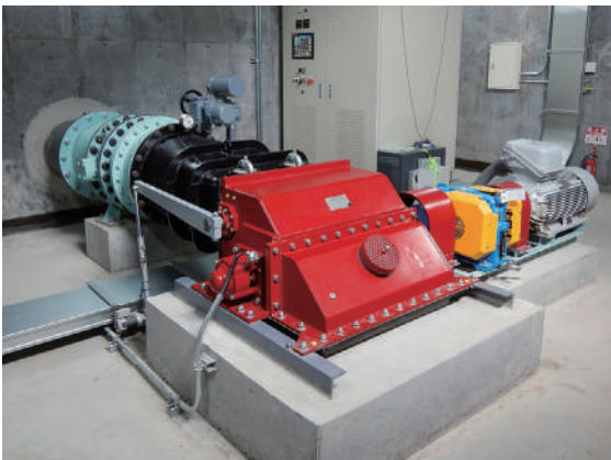
▲韓国の水車メーカーKUMSUNG E&C社の横軸クロスフロー水車。発電機は、安川電機の永久磁石形三相同期発電機を使用。
