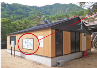
▲発電所建屋。発電所前にある木製水車や、金剛の滝の景観に調和するデザイン。壁面にあるパネルでは、恐竜のイラストを使って、水力発電のしくみをわかりやすく説明している。
