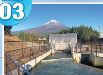
三峰川本門寺 第一・第二発電所 (静岡県) 協力／三峰川電力株式会社
