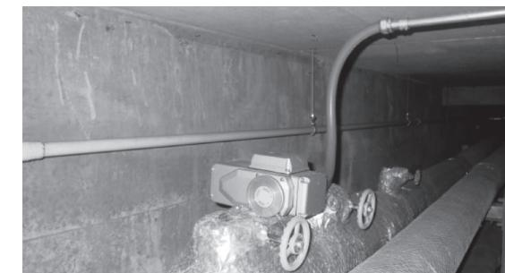
写真1 増設した電動弁
