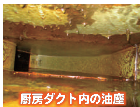
油塵によるダンパー固着
