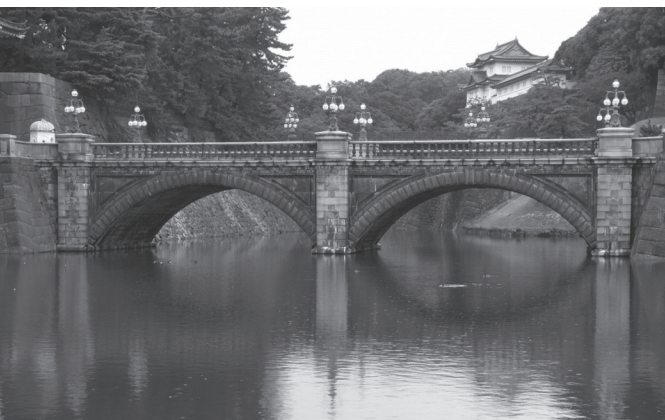
土木構造物：橋
